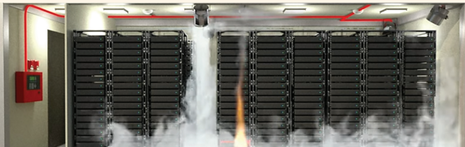
冷凝气溶胶发生器可为 BESS 提供全淹没式灭火保护
